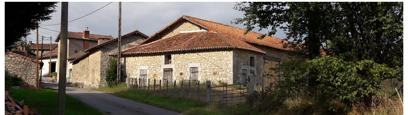
Photo 39 : Bâti traditionnel au hameau Fianas sur le secteur de Chamborêt
