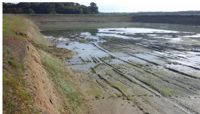
Bassin d'irrigation présent sur l'aire d'étude de Berneuil
