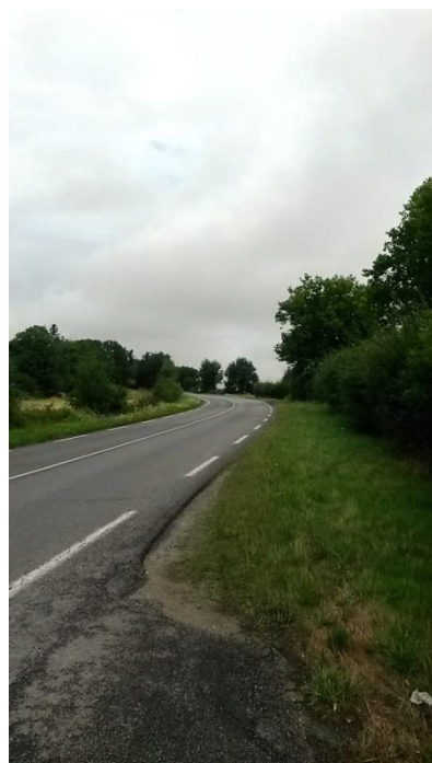
Photo 28 : RN 147, vue depuis l'extrémité sud de la section sur la commune de Chamborêt
